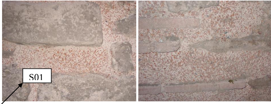
Şekil 18. Anemas Zindanları restorasyonu sırasında kullanılmış olan onarım harcından incelenmek üzere alınan örnek yeri
