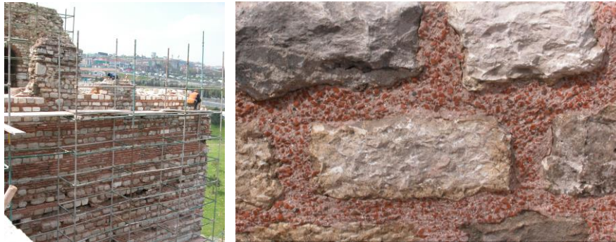
Şekil 16. Anemas Zindanları restorasyonu sırasında kullanılan onarım harcının durumu (2006).
