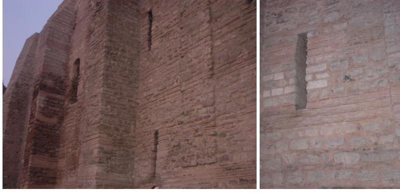
Şekil 17. Anemas Zindanları restorasyonu sırasında kullanılmış olan onarım harcının 1 yıl sonraki görüntüleri (2007).
